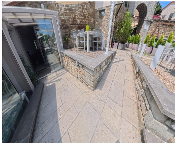
Figura 27 doppia rampa ingresso locale
