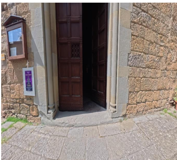
Figura 23 portale di ingresso chiesa
